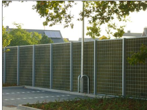
Absorberende zijde net & gaas Achterzijde gecoate plaat
